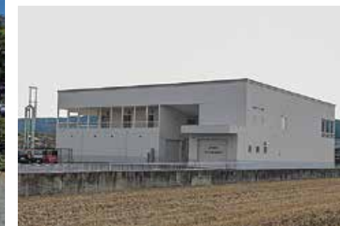
森町拠点防災倉庫
