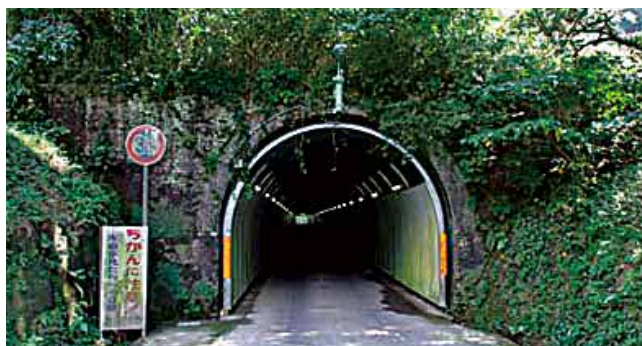
東側にある青田隧道
