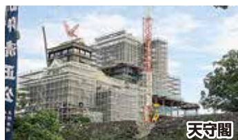
天守閣 工事用のメッシュシートには透過性のあるシートが採用され、復旧作業の様子を見ることができます。
