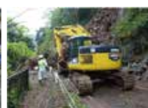
土砂崩壊復旧工事
