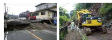
道路陥没埋戻し
