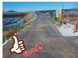
工事車両の通行を確保するための養生(路肩確保のため)。
