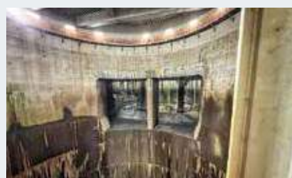
第1立坑からみた調圧水槽
