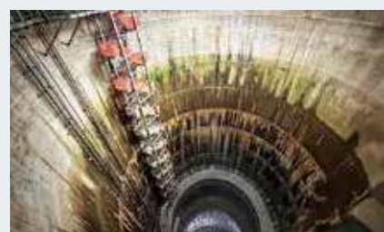
第1立坑(ハーネス、ヘルメットを装着して見学)
