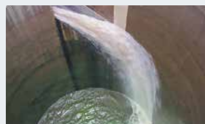
稼働時の流入状況
