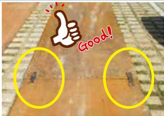
敷鉄板をプレートにて溶接することにより、ずれ防止と盗難防止対策が講じられている
