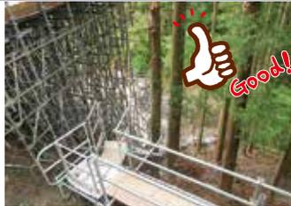
昇降設備が作業箇所だけでなく、河川まで安全に降りられるように整備されている
