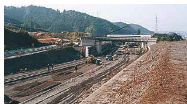
施工中(2001年12月撮影)
