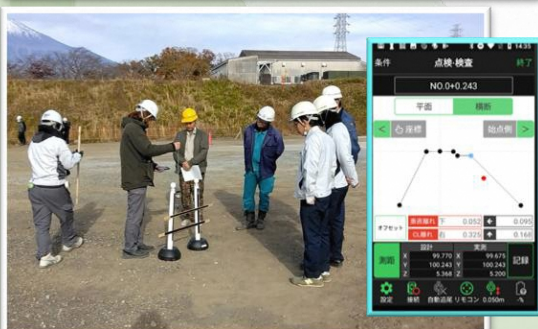
TSを用いた位置だし・丁張体験・出来形管理
