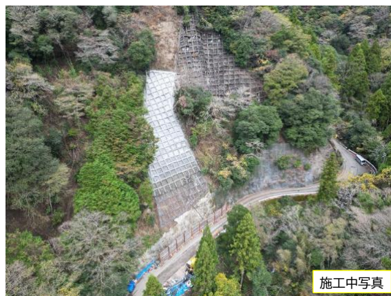
図5: 吹付法砕工展開図 及び 施工中写真
