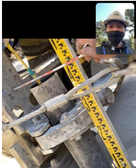
図45： 鉄筋挿入工(ロックボルト工) 遠隔臨場(ヤードと法面)
